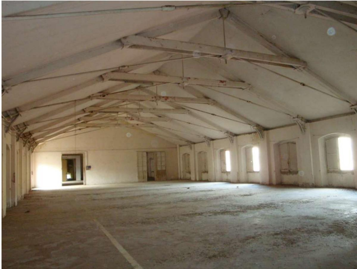
Foto della copertura a capriate metalliche presente sul braccio nord della C della originaria struttura dell'opificio
